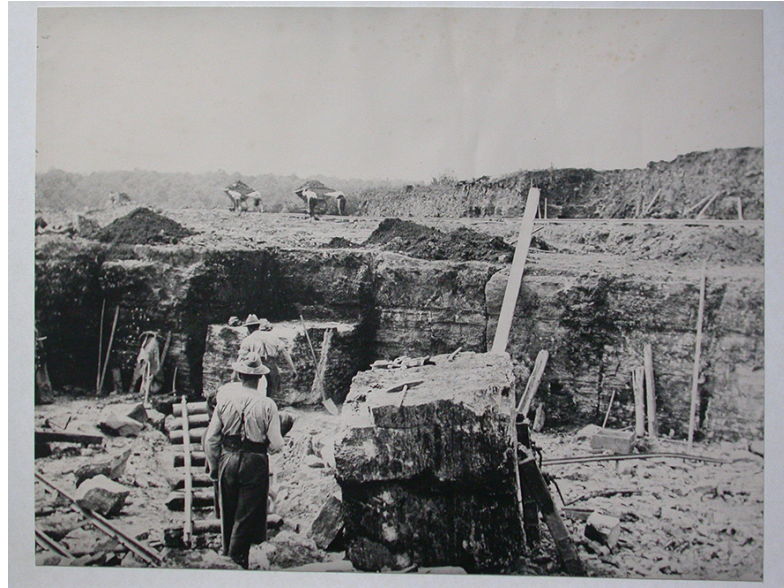
Das Bild zeigt den terrassenartigen Abbau der Erdschichten und die grobe Zurichtung der Steinblöcke im Steinbruch.
